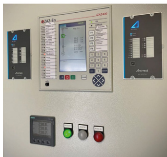
Rys. 3. Zabezpieczenie AQ-110PLV zamontowane na drzwiczkach Fig. 3. AQ-110PLV arc flash protection mounted on the door
